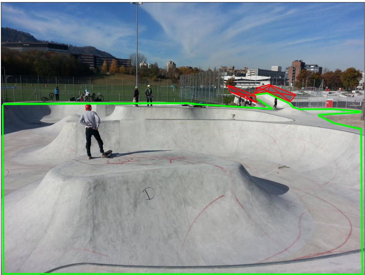
Bild 1 - Pools im südlichen Teil der Anlage
