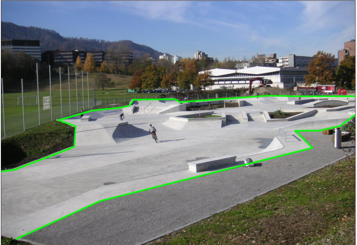
Bild 2 - nördlicher Teil der Anlage
